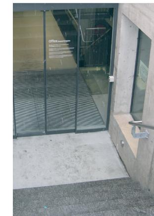
Parallel zum Glasbau führt eine Treppe zu den Parkgeschossen. Der Übergang ist mit einer Glastüre abgeschlossen. Ein grosses Glasfenster ermöglicht eine Kontrolle von der Portiersloge.
