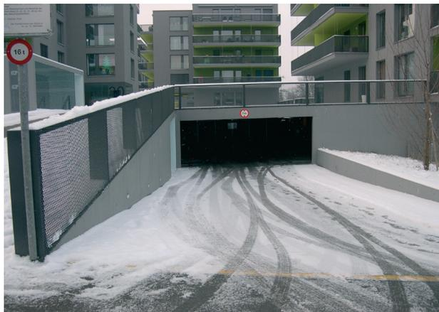
Der Fuss- und motorisierte Verkehr wird in dieser Überbauung vorbildlich getrennt. Ein transparentes Metallgeländer sichert die Einfahrt. Durch die niedrig gehaltene Mauer kann vermehrt Tageslicht in den Innenraum einfallen.
