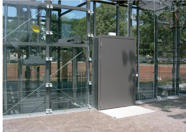
Die Vertikalerschliessung der Parkgarage ist vollkommen licht- und sichtdurchlässig. Lift und Aussenhaut sind aus Glas. Der Glaskubus ermöglicht, dass Tageslicht in das Parkgeschoss dringt und die Treppenanlage tagsüber sehr hell ist.
