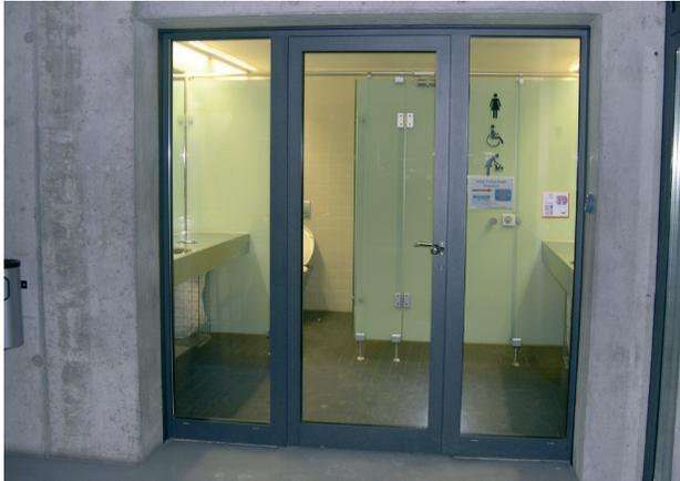
Die Glastüre zum WC ermöglicht eine Einsicht, sie lässt eine soziale Kontrolle zu. Die satinierten Glaswände zu den Toilettenkabinen haben einen Bodenabstand, so dass ein Sich-Verstecken hinter der geschlossenen Tür verhindert wird.
