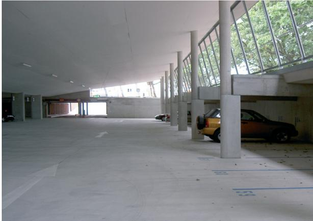
Das geschwungene Dach bringt viel Licht in die Parkgarage. Die tragenden Pfeiler und Stützen sind minimal dimensioniert. Ausser entlang der Längsfassade verstellen keine tragenden Elemente die Parkfelder, und auch hier nur in einem grossen Abstand. Deckenlampen beleuchten nachts die Tiefgarage.
