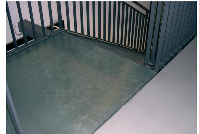
Die Vertikalerschliessungen sind gut über den Grundriss verteilt. Dadurch bestehen keine weiten Wege zu den Ausgängen. Satiniertes rutschfestes Glas auf den Treppenstufen lässt das Licht bis in die unteren Parkdecks.
