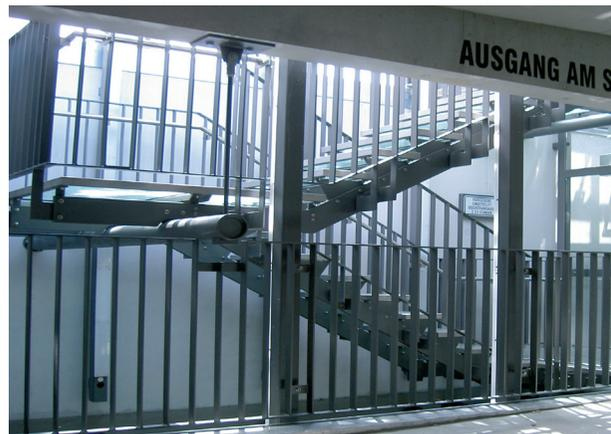
Die Treppenanlage bringt viel Licht in die Parkgarage. Bewusst wurde ein transparentes Geländer gewählt. Die Treppenstufen sind aus rutschsicherem Sicherheitsglas, welches die Sicht in die grüne Umgebung der Anlage bereits beim Hinaufsteigen durchscheinen lässt.
