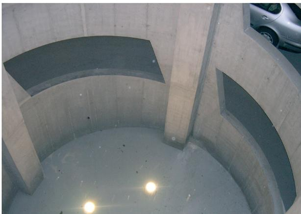
Die Parkdecks werden durch zwei Rampenanlagen erschlossen. Diese sind mit grossen Öffnungen durchbrochen welche Durchsicht und Tageslichteinfall ermöglichen. Die Rampe wird vom Boden her mit Strahlern beleuchtet.
