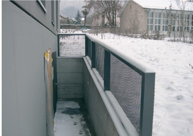
Einer der Ausgänge zur Gartenanlage. Auf ein massives Geländer wurde verzichtet, um mehr Tageslicht in den Parkraum zu führen. Gut verteilt über die Tiefgarage gibt es zusätzliche Ausgänge zur Aussenanlage.
