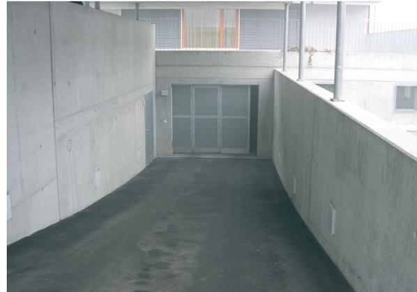
Die gedeckte Einfahrt ist durch die grossen Öffnungen tagsüber sehr hell. Das seitlich öffnende Garagentor ist aus einem lichtdurchlässigen Gitterrost. Ein Sicht- und Hörkontakt ist möglich.
