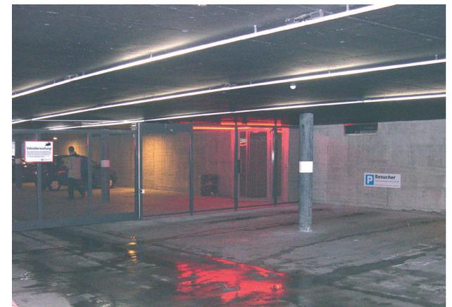
Anstatt einem geschlossenen Garagentor zwischen zwei Mauern besitzt diese Parkgarage eine Abtrennung durch Gittertore und Gitterwände über die ganze Breite. Bereits am Eingang ist die Sicht über das ganze Parkdeck möglich.
