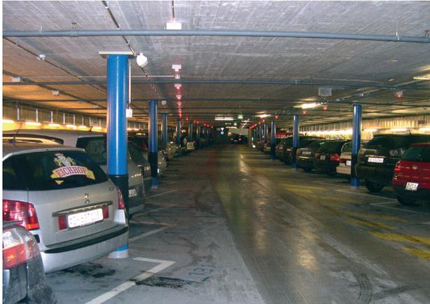
Die Parkgarage zeichnet sich aus durch einen übersichtlichen Grundriss mit minimaler Stützenszahl und schmale Stützen. Die Einbahnregelung sowie die Schrägparkierung vereinfachen das Ein- und Ausfahren aus den Parkfeldern.
