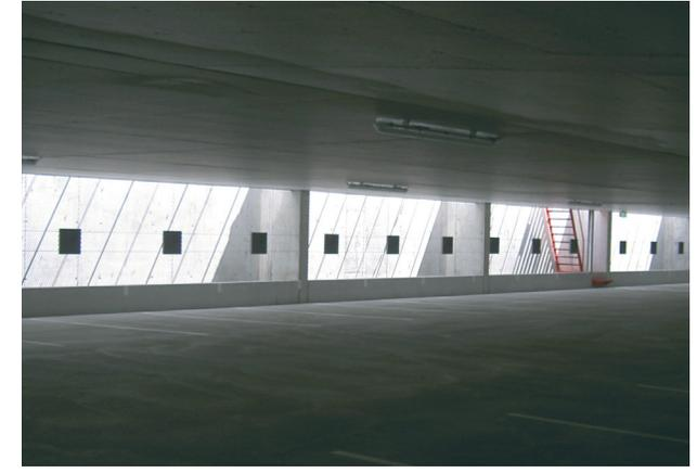
Das Gitter gibt tagsüber eine abwechslungsreiche Lichtkulisse. Zwei gespannte Metallseile mit quadratischen Platten soll den Übergang zum Aussenbereich anzeigen und ein regelmässiges Betreten der gefüllten Kieswanne verhindern.
