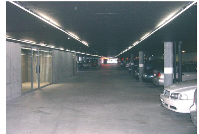
Die Aus- und Einfahrt befinden sich bei dieser Garage am selben Ort und so muss der Gegenfahrbahn- wie auch der Fussverkehr auf der selben Fläche geführt werden. Die Fahrbahn ist deshalb grosszügig bemessen. Vor dem Eingang ins mittlere Wohngebäude ist bewusst kein Parkplatz eingeplant.
