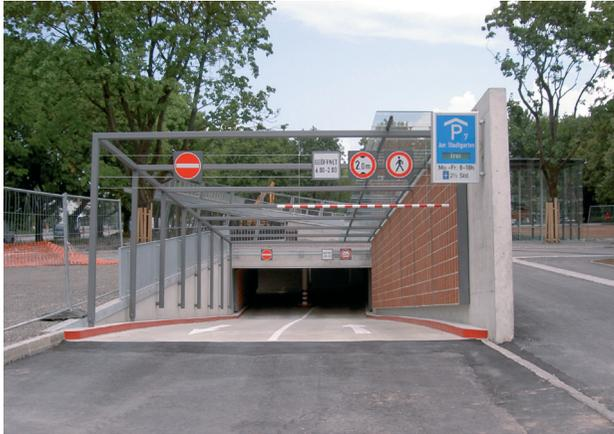
Die Einfahrt in die Tiefgarage ist sowohl mit einer seitlichen Betonwand, als auch mit einem transparenten Geländer vom Fussverkehr getrennt. Eine poröse Wandaufdoppelung, sowie ein einseitiges Glasdach dämpfen einen Teil des Fahrlärms.
