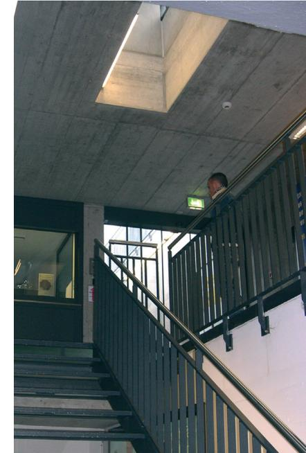
Die Treppe führt an der Portiersloge vorbei. Tageslicht kommt über das Oblicht in den Raum, unterstützt durch zum Teil versteckte Neonröhren. Die Wände im Treppenhaus sind hell gestrichen.
