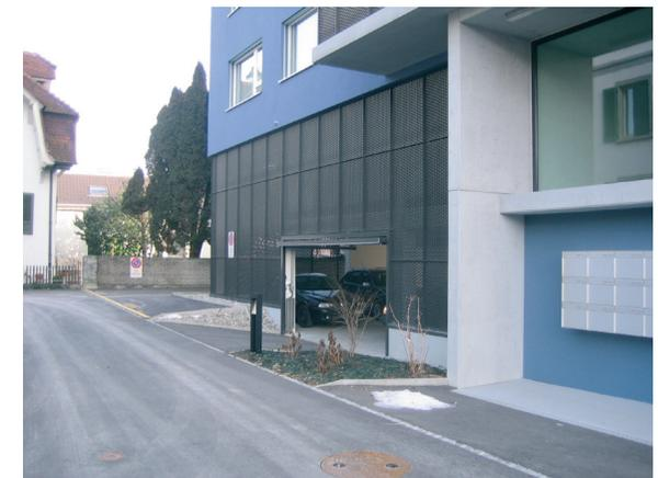
Die Einstellhalle mit ihrer zweigeschossigen Metallmembran wirkt von der Ferne als geschlossene Fassade und ist Teil des gestalterischen Ausdrucks. Die Eingangspartie mit Treppenanlage, Tür und Briefkastenelementen wurde in diesen dunklen Sockel hineingestanz.
